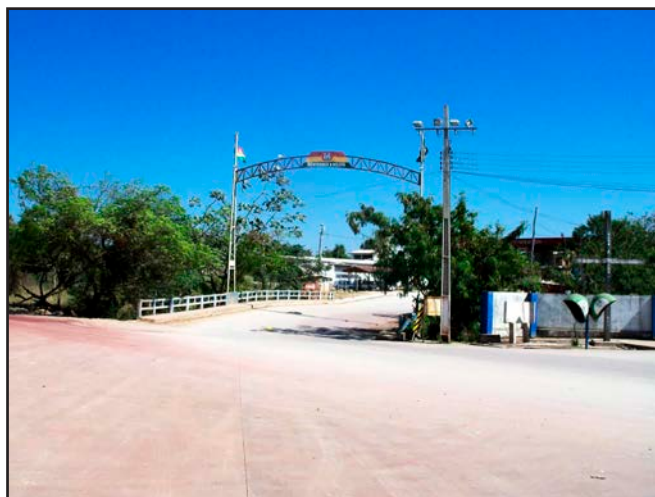
Figura 11. Puente entre los controles fronterizos de Brasil y Bolivia.
